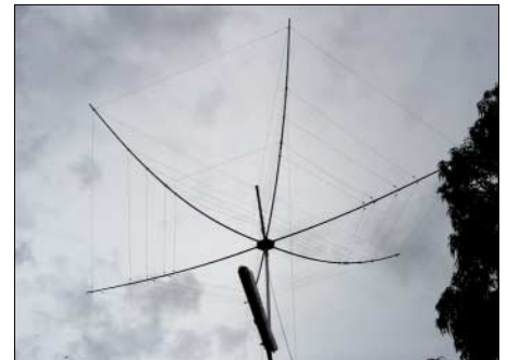
Der 5-Band-Hexbeam an einem ausgedienten Laternenmast
